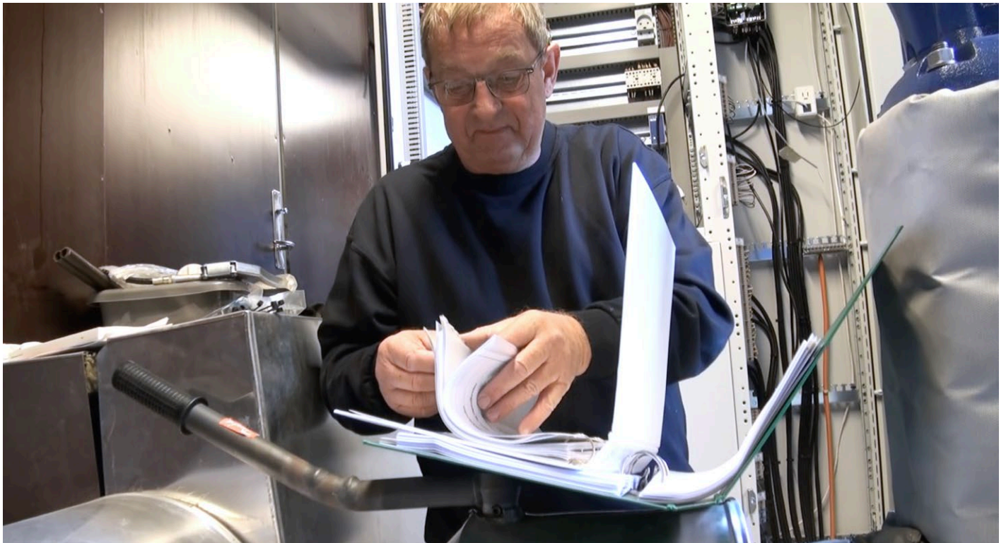
Jens Ole Olsen, mandor di Hirtshals Fjernvarme, memasang monitor pengawasan elektronik pada pompa CR-95 di stasiun pemompaan Tornby.
